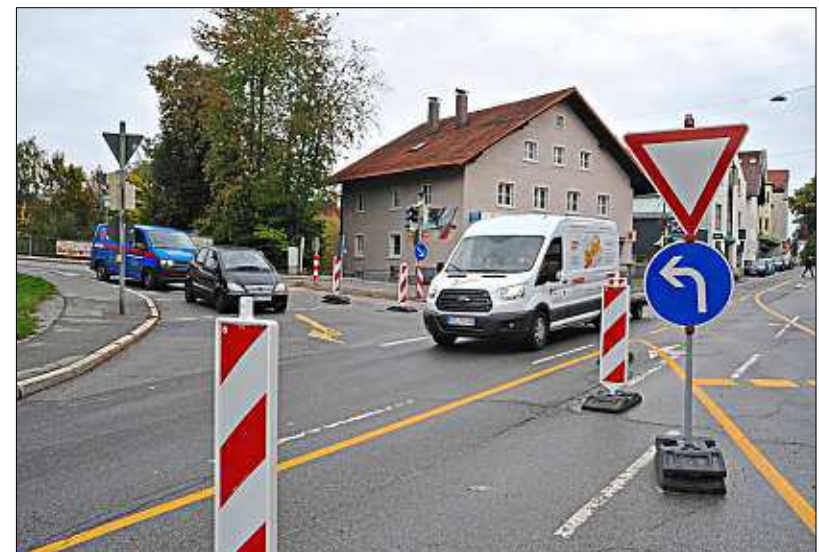
Die provisorische Verkehrsführung am Moizerlitzplatz, die einem Kreisverkehr gleicht, funktioniert gut. Jetzt wird die Idee verfolgt, die Ampeln mit Hilfe eines richtigen Kreisverkehrs überflüssig zu machen. – F.: Lukaschik
